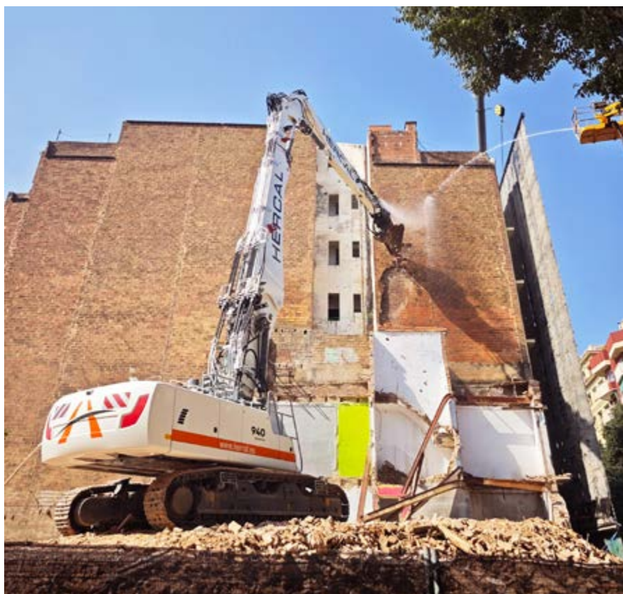
Hercal adquiere la primera unidad en España de la excavadora Liebherr R 940 Demolition.
