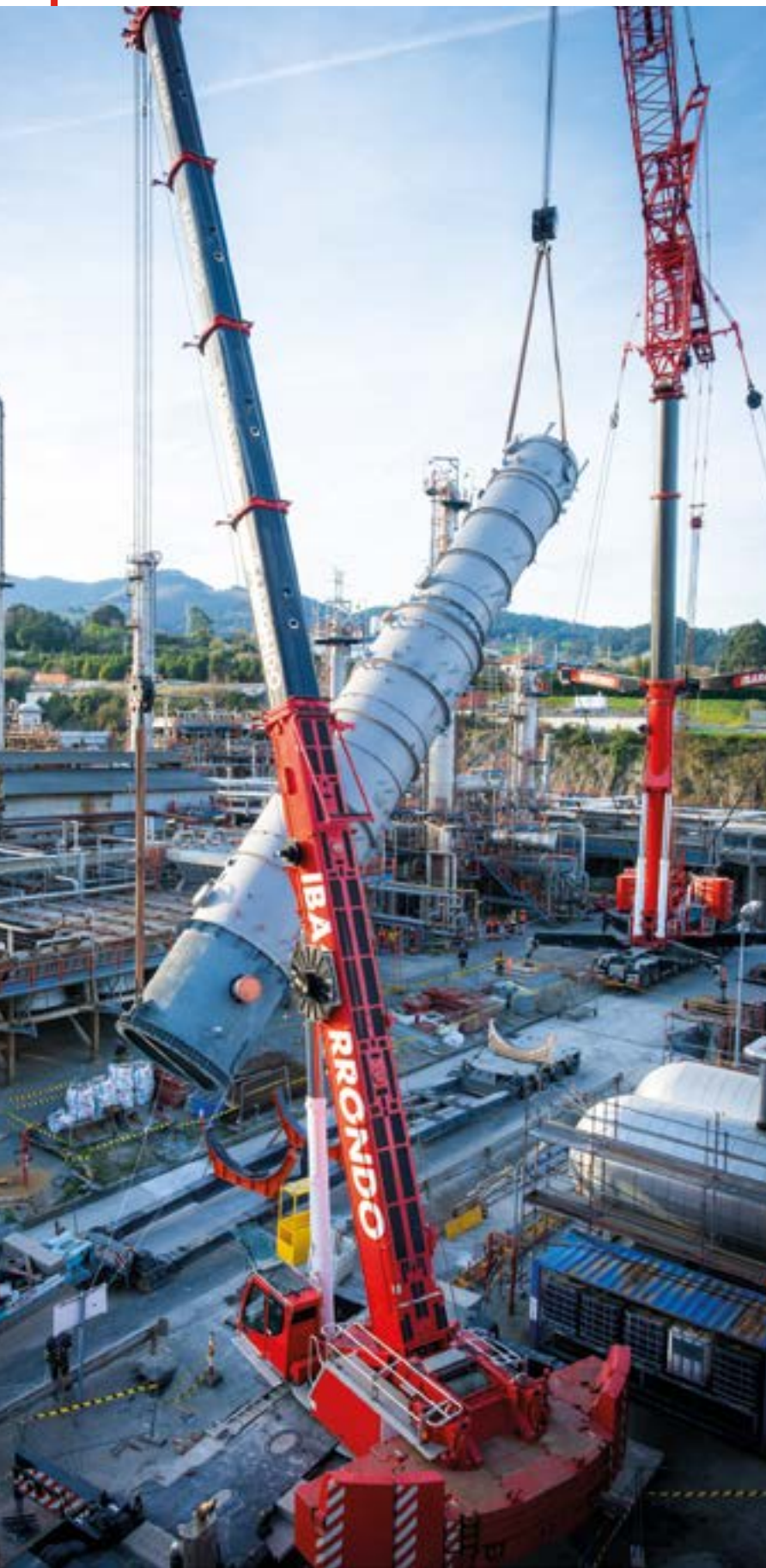
Instalación de Torre Preflash, Petronor
