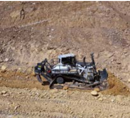
El bulldócer Liebherr PR 776 trabajará, como el resto de los equipos de la compañía, a jornada completa, preparando el material para su carga y posterior transporte a la obra.
