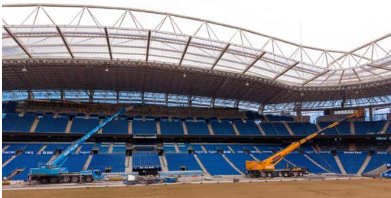
Las grúas Liebherr LTM 1300-6.4, LTM 1250-5.1 y LTM 1230-5.1, de Usabiaga, y la LTM 1200-5.1 de Grúas Vallarín izarán cargas de hasta tres toneladas de peso, a radios de trabajo de hasta 72 metros.
