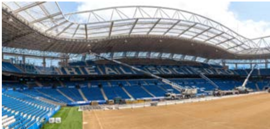
Uno de los grandes hándicaps del proyecto fue el reducido plazo de ejecución, ya que los trabajos tienen que llevarse a cabo entre el final de la temporada de Liga y el inicio de la siguiente, a finales de agosto.
