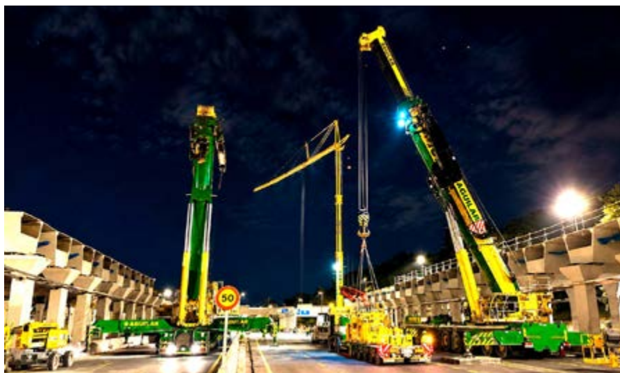
Grúas Aguilar participa en la construcción del nuevo Parque Ventas con siete grúas móviles Liebherr, con capacidades de carga entre 100 y 800 toneladas.
