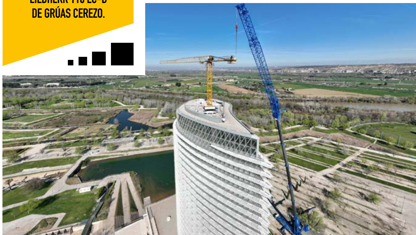
La grúa Liebherr 110 EC-B de Grúas Cerezo trabajará en la ampliación de la emblemática Torre del Agua de Zaragoza que contará con un mirador 360° y una nueva zona de restauración.
