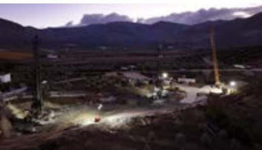
En este proyecto, la maquinaria Liebherr de Pilotes Sánchez trabaja las 24 horas del día.
