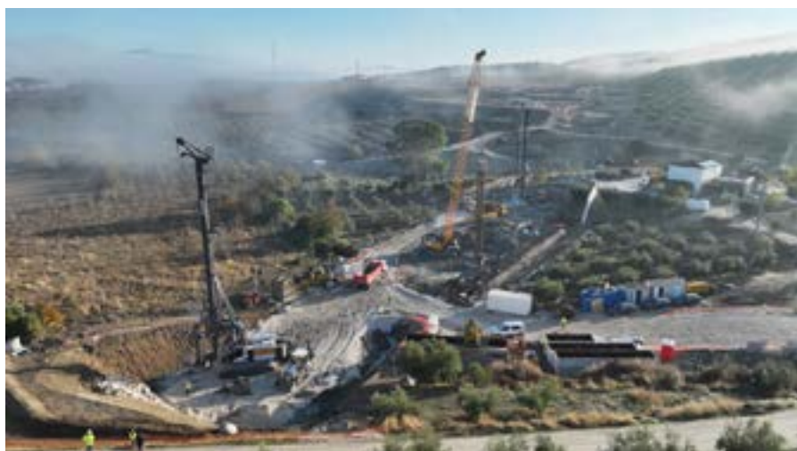
Las pilotadoras de rotación Liebherr LB 35, LB 36 y LB 45.1, junto con la grúa de cadenas Liebherr HS 855, todas ellas de Pilotes Sánchez están trabajando en la construcción del AVE de Málaga a Granada, en su variante de Loja.
