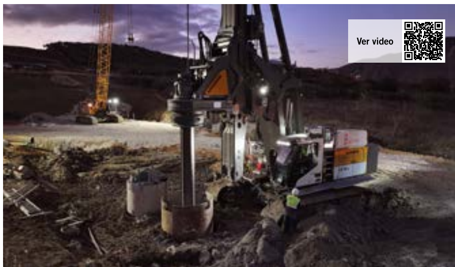
Las pilotadoras de rotación Liebherr LB 35, LB 36 y LB 45.1 de Pilotes Sánchez ejecutan pilotes de 1800 mm de diámetro y de hasta 35 metros de profundidad.
