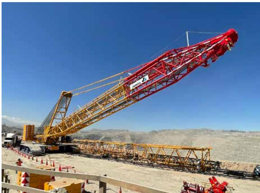
Una vez completamente montada, la CC 38.650-1 colocó la primera sección de 80 metros de largo y 247 toneladas de la cinta sobre dos soportes previamente erigidos. El proceso se repetirá varias veces hasta completar la cinta transportadora, que tendrá una longitud total de 900 metros y llegará hasta el fondo de la mina.
