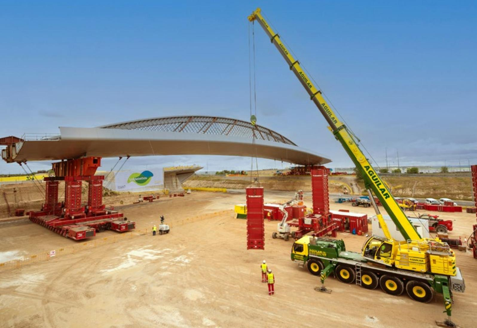
La grúa móvil Liebherr LTM 1100-5.2 de Grúas Aguilar realizó trabajos auxiliares, como el posicionamiento de los carros modulares y de las vigas metálicas, durante el montaje del Puente de la Concordia, en Madrid.
