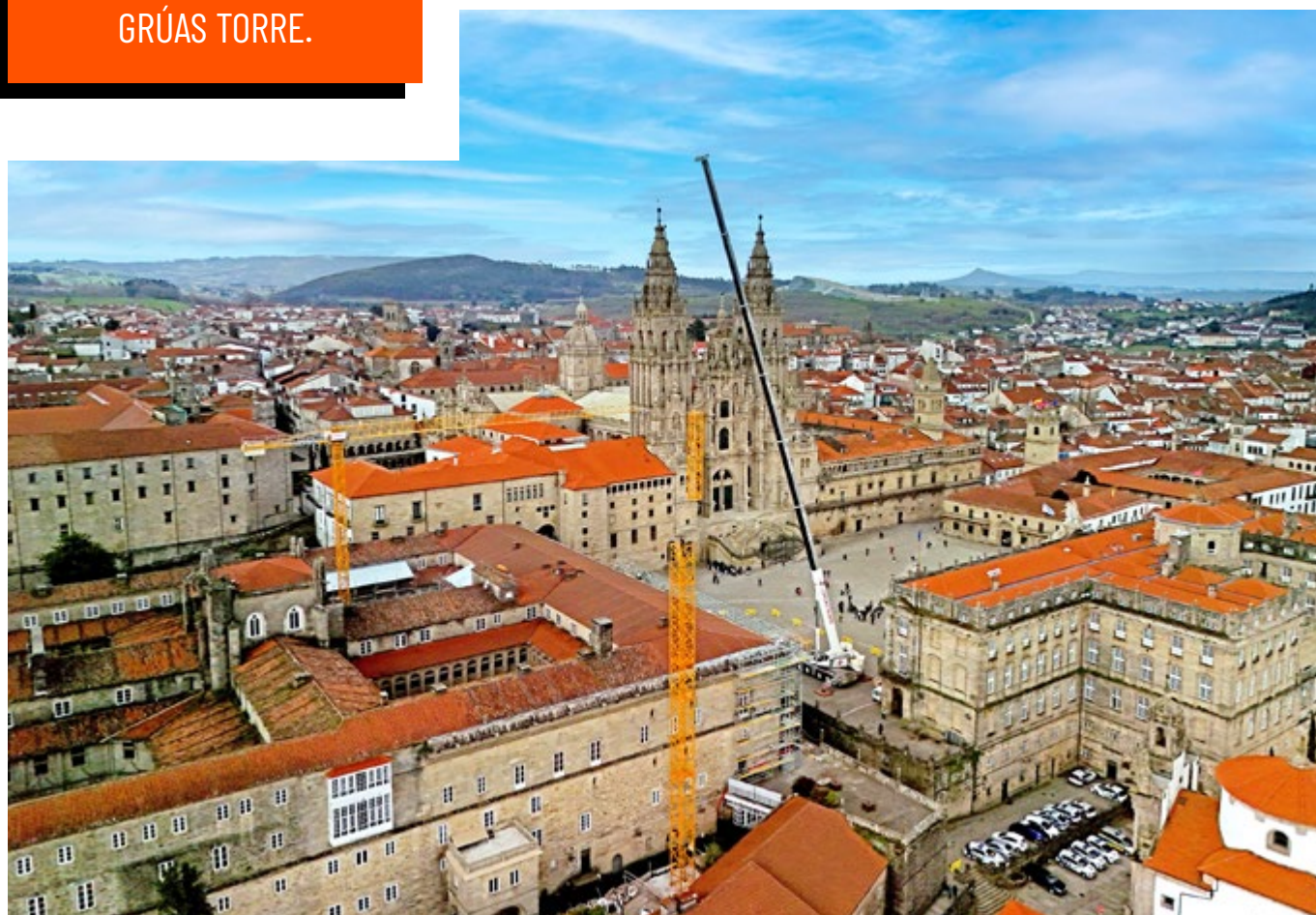
La grúa móvil Liebherr LTM 1300-6.2 de Grúas Norte fue el equipo elegido para el montaje de las grúas torre Liebherr 125 EC-B y 71 EC-B de Maga Vigo.
