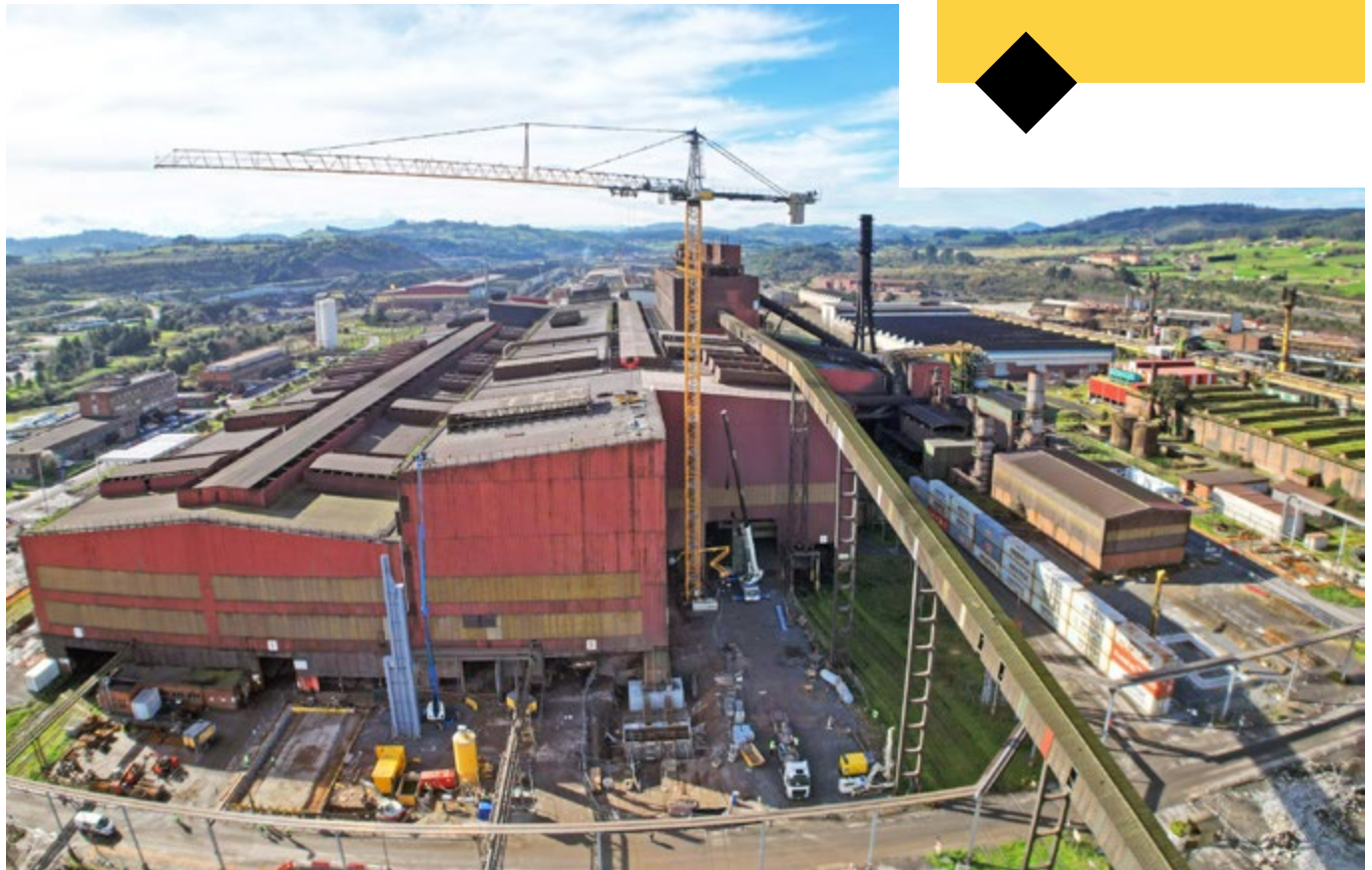
ArcelorMittal construirá un horno de arco eléctrico con la primera unidad Liebherr 1188 EC-H 40 Fibre en España.
