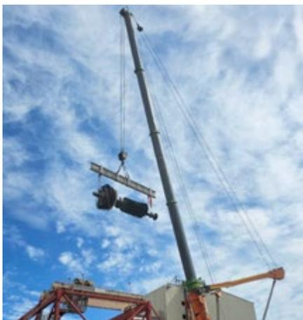
Izaje de Turbina Grúa de 1200 Tons
