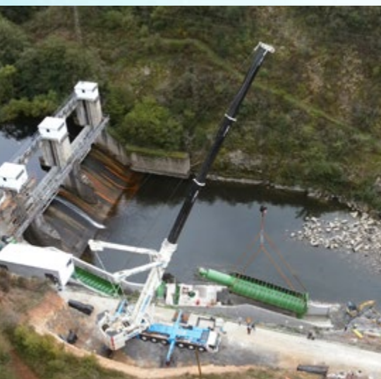
Montaje del mayor hidrotornillo de Europa, Prieaños, Asturias.
