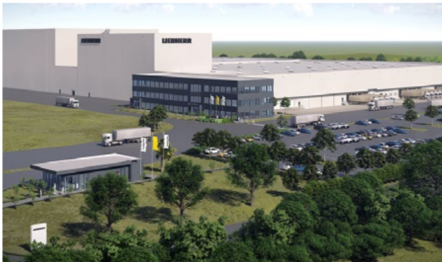
Una vez completado, se espera que el nuevo centro logístico cree 180 nuevos puestos de trabajo en el área alrededor de Tupelo, Mississippi (EE. UU.).
