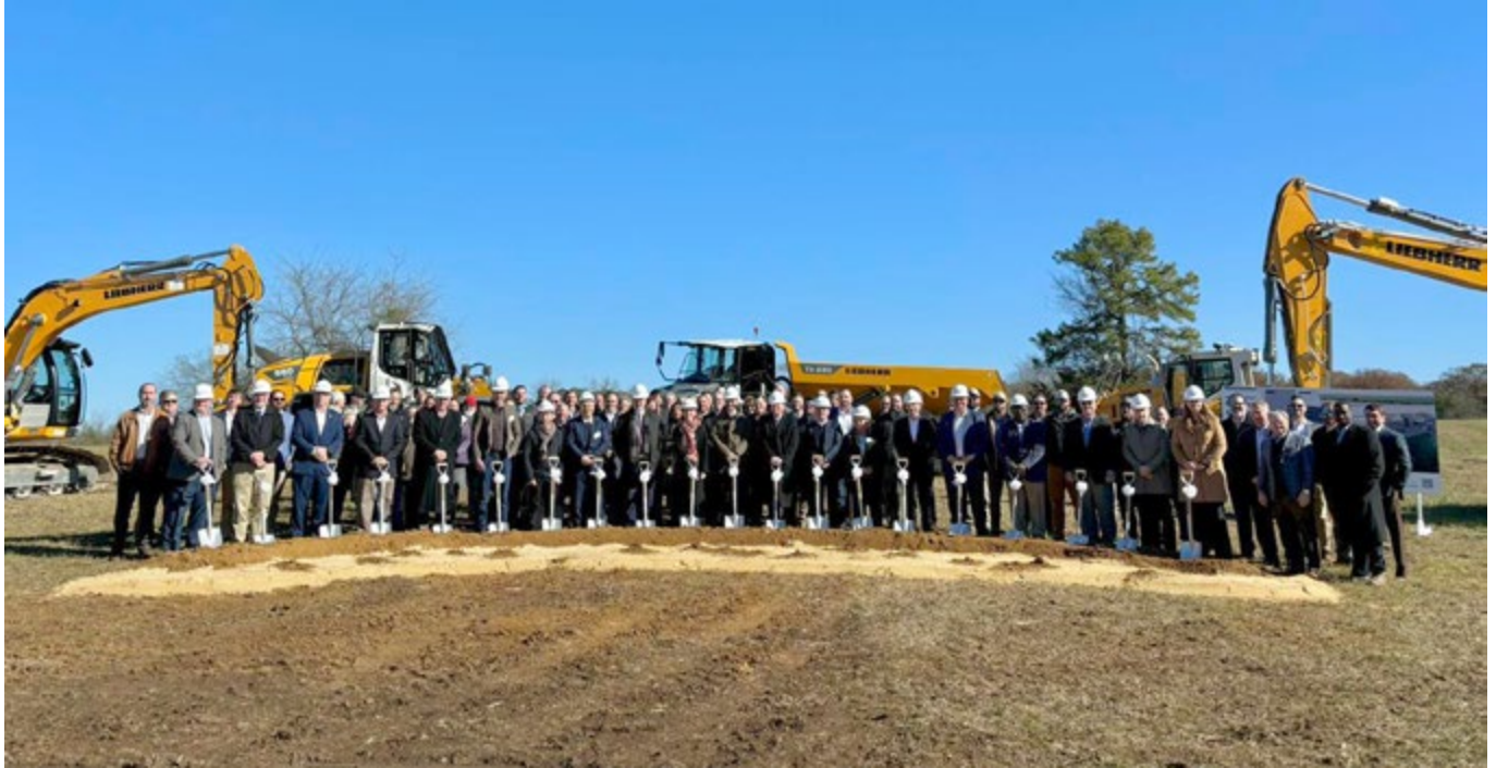
Representantes del Grupo Liebherr, el gobernador de Mississippi y funcionarios de la ciudad de Tupelo celebraron la ceremonia simbólica de inicio de obras del nuevo edificio de Liebherr Logistics USA Ltd. en Tupelo, MS (EE. UU.).
