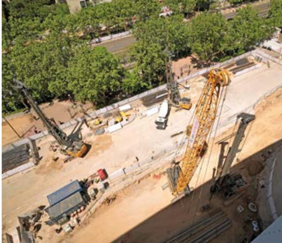
Las pilotadoras de rotación Liebherr LB 16, LB 20 y LB 28-320, así como la grúa sobre cadenas Liebherr HS 853 HD van a ejecutar pilotes y pantallas discontinuas que servirán de base para las losas y forjados, así como para las rampas de acceso, entre otros trabajos.
