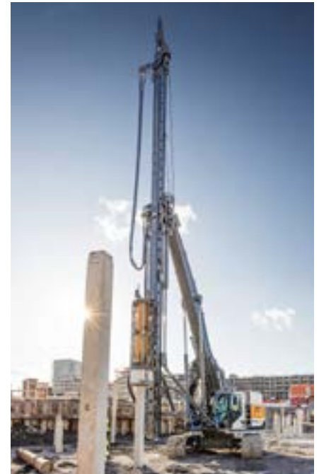
La LRH 100.1 unplugged hincando pilotes en el suelo con el martillo H 6 en Karlstad, Suecia.
