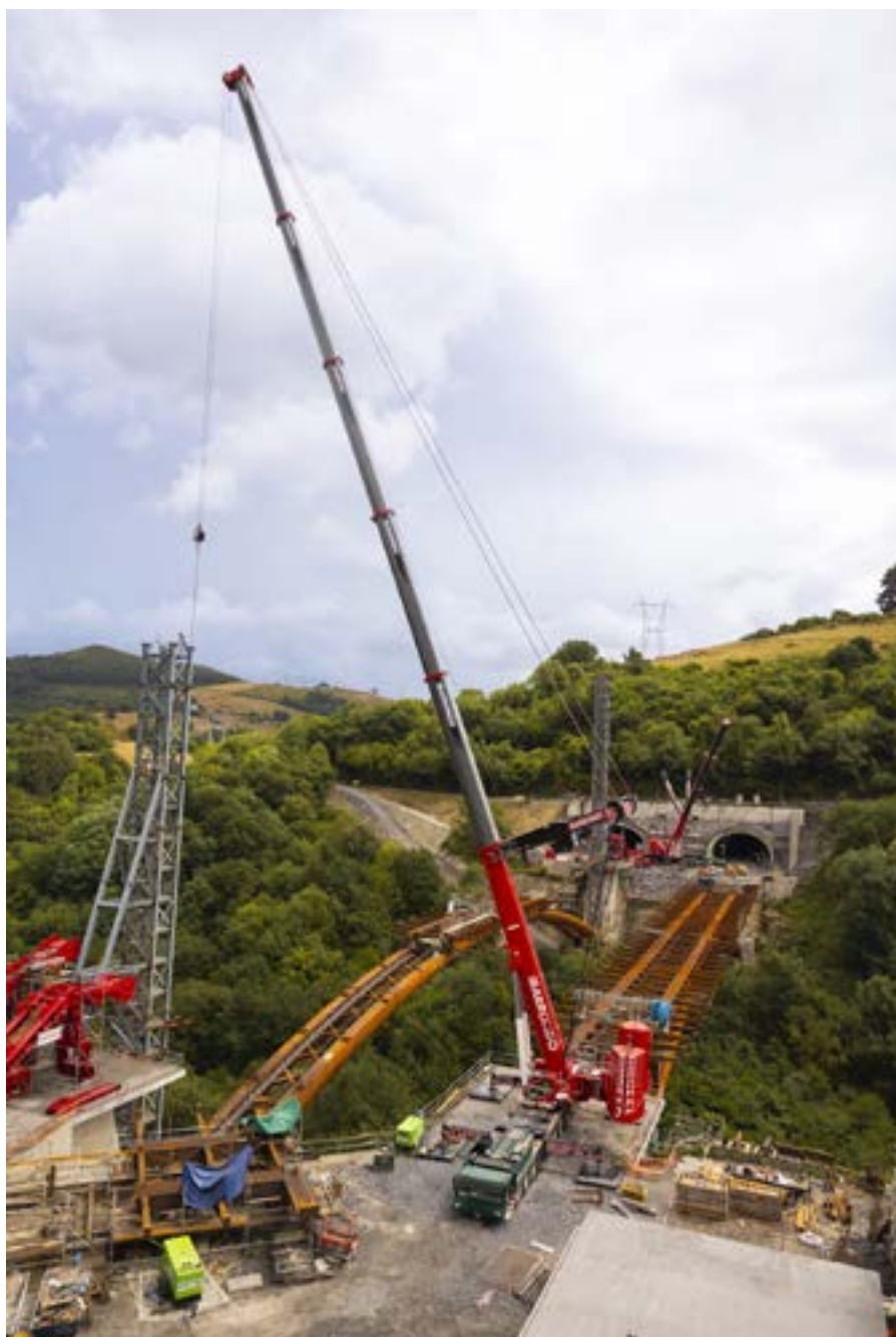
Instalación de dos viaductos, de 233 y 220 metros de longitud, a una altura de 70 metros aproximadamente.
