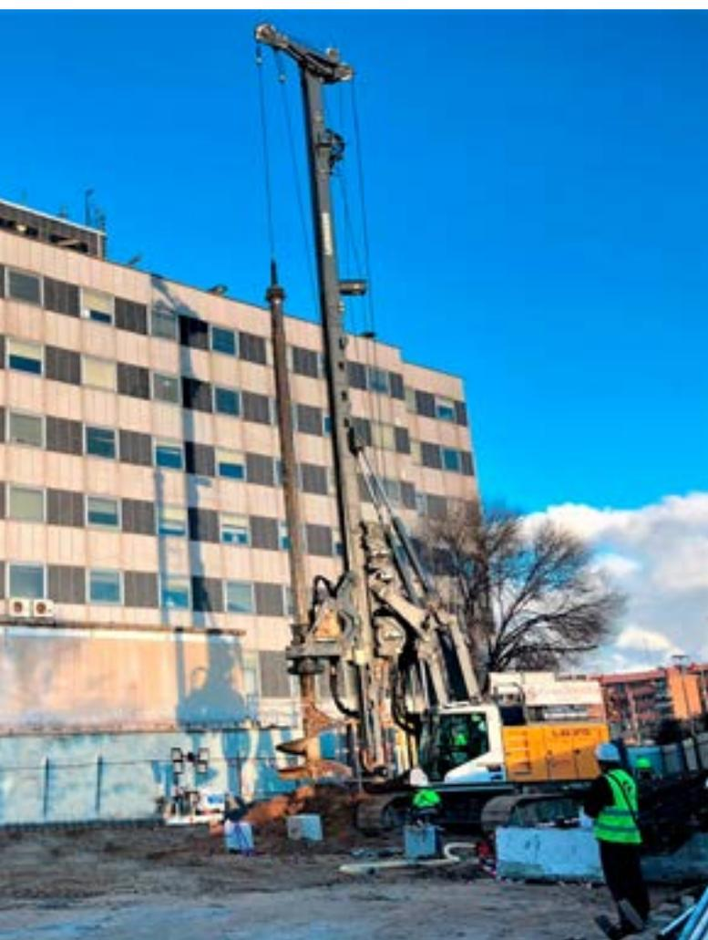
La pilotadora de rotación Liebherr LB 25 de Pilotes Sánchez ejecuta 5.000 metros de pilotes en pantallas secantes de diámetro 800 milímetros y de hasta 38 metros de profundidad, dentro de las obras de renovación del metro de Begoña.
