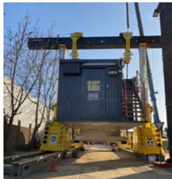
zarse y utiliza el sistema de control inalámbrico Intelli-lift para un movimiento sincronizado, mayor seguridad y control del operador.
