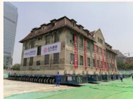
de longitud, 16 metros de ancho y 16 metros de alto, con un peso total de aproximadamente 2.600 toneladas. Para su transporte fueron necesarios remolques de 120 ejes y grúas para ser capaces de elevar su peso. La reubicación tuvo que sobrellevarse con mucho cuidado debido al deteriorado estado del edificio y su facilidad para dañarse, pero gracias a la experiencia y profesionalidad de Sarens, el proyecto fue todo un éxito y el convento fue reubicado con total seguridad y sin ningún daño.
