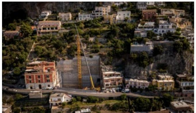
Una grúa todo terreno Grove GMK4100L-1 ensambla la grúa torre Potain MDT 189 para ayudar a construir un estacionamiento de varios niveles con elevador en la superficie de la roca
