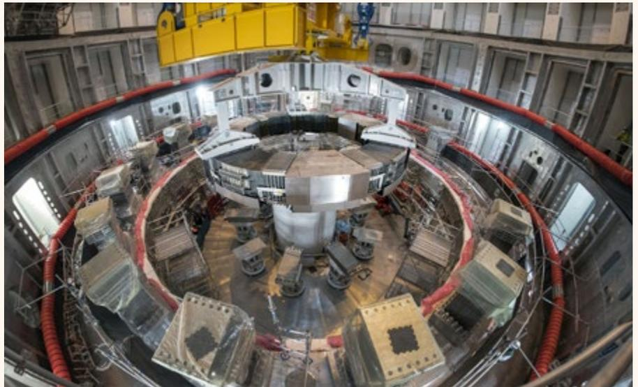
siguiente nivel de vigas de la pila, y el proceso se repite hasta que el imán queda finalmente atornillado al tokamak.
