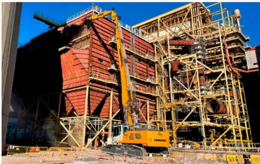
La excavadora de cadenas Liebherr R960 Demolition de AFESA Medio Ambiente está realizando trabajos de demolición en altura, tanto de hierro como de hormigón, en las centrales térmicas de Velilla del Río Carrión (Palencia) y de Meirama (La Coruña, Galicia).
