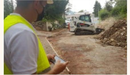
fuerza de arranque para la manipulación de tierras y capacidad de elevación para vaciar camiones del material de relleno. Posee elevadas capacidades nominales de funcionamiento, ciclos más breves y giros más rápidos.
