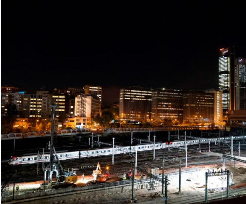
La pilotadora de rotación Liebherr LB 24-270 de Cimentalia tuvo que enfrentarse a diversos retos, entre otros, las condiciones inherentes a realizar los trabajos entre las vías, el reducido espacio y el horario nocturno limitado, para evitar la circulación de trenes.
