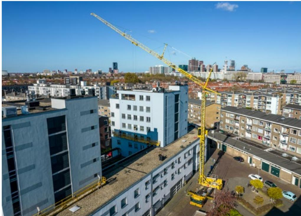
En Voorburg, la MK 73-3.1 aprovecha al máximo su alcance para trasladar plataformas para trabajos de pintura con un peso de aprox. 800 kg.
