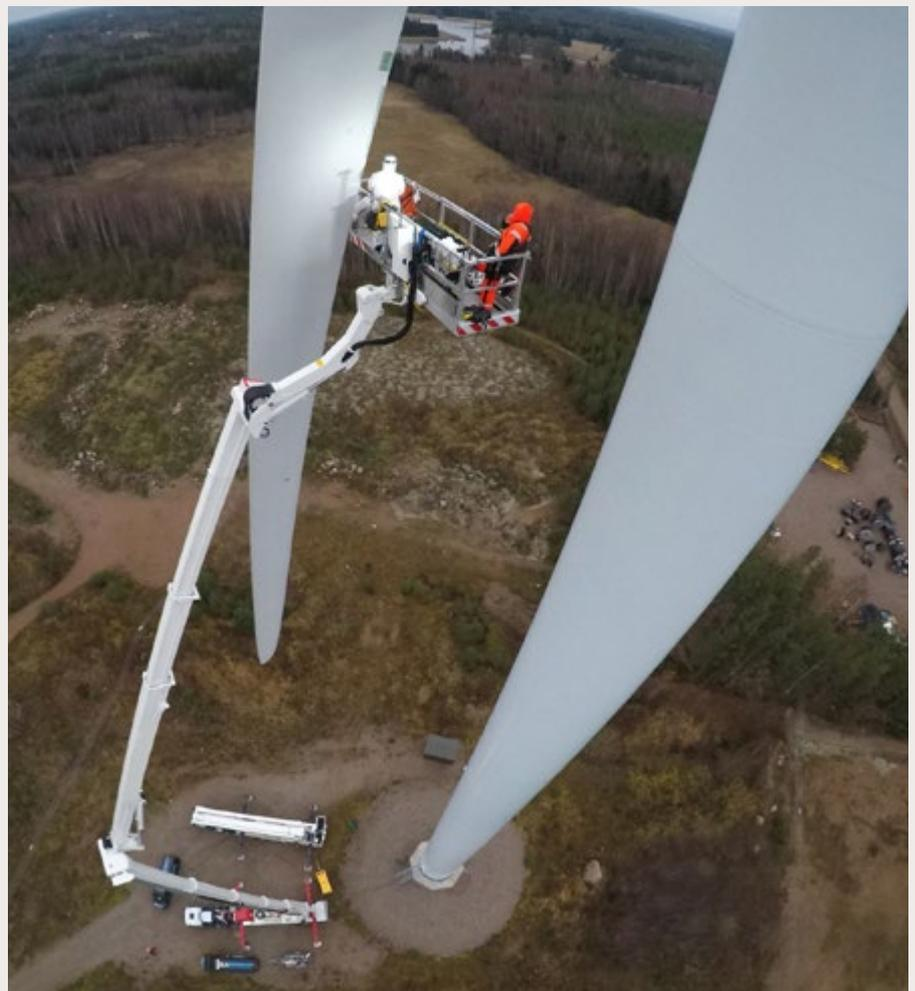
Fotografía desde la plataforma Bronto S104HLA (104 metros) que se refleja trabajando la plataforma aérea de 90 metros. Esta foto refleja la diferencia en altura entre 90 metros y 104 metros.
