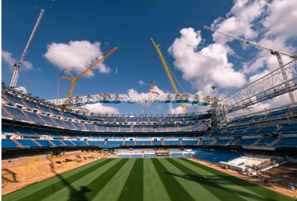
**Obra segura – Grúas Aguilar y Eurogrúas 2000 simularon los izados previamente, para que luego pudieran colocar perfectamente las cerchas de la nueva cubierta.**
